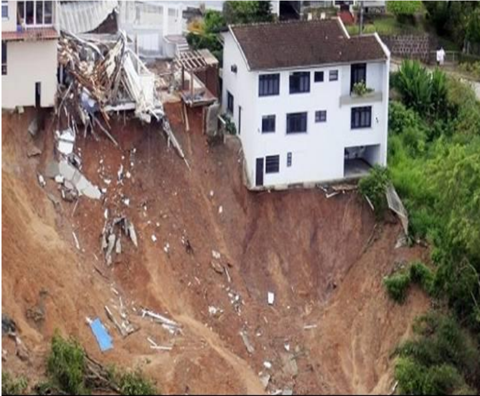
Figura 4: Desmoronamento de morros e encostas em Blumenau no ano de 2008.
